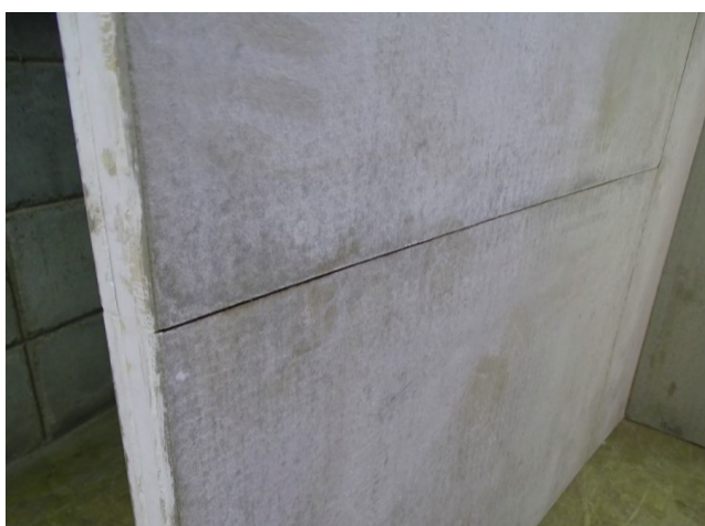
Fot 11 – Vistas das juntas entre os painéis.
